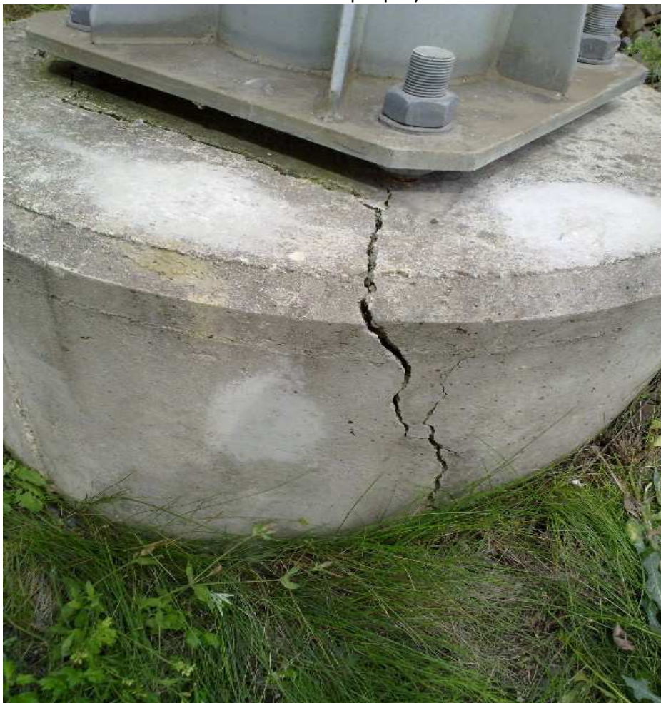
Obr: Koroze betonového základu trakční podpěry
